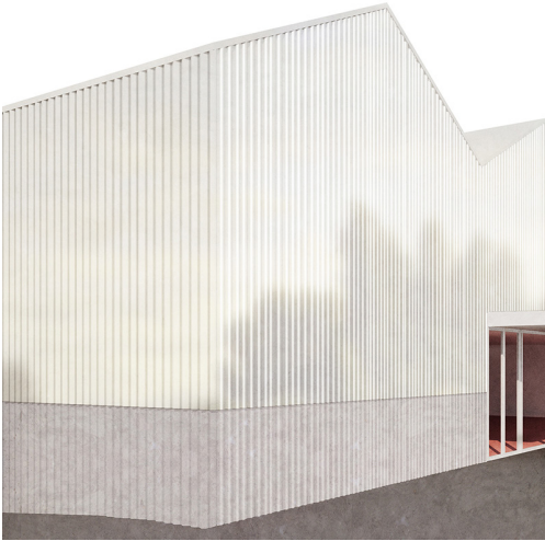
Gebäudeecke Südost - Variante Betonsockel gewellt
